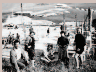
L'hôtel actuel en construction, en 1953 (Hubert au centre).
