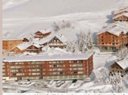
Vue de l'extension et des deux ailes à
